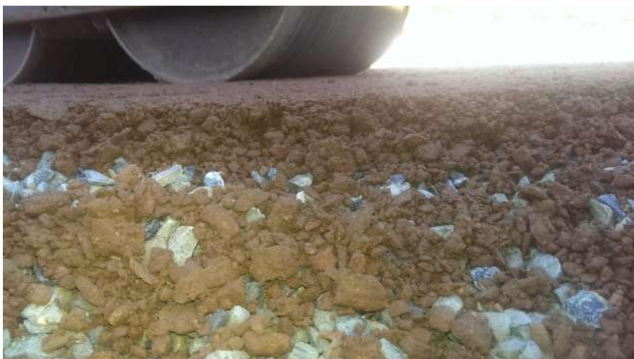
Auf diese „Dynamische Schicht“ wird dann die Deckschicht aufgetragen und der Sand eingestreut.
