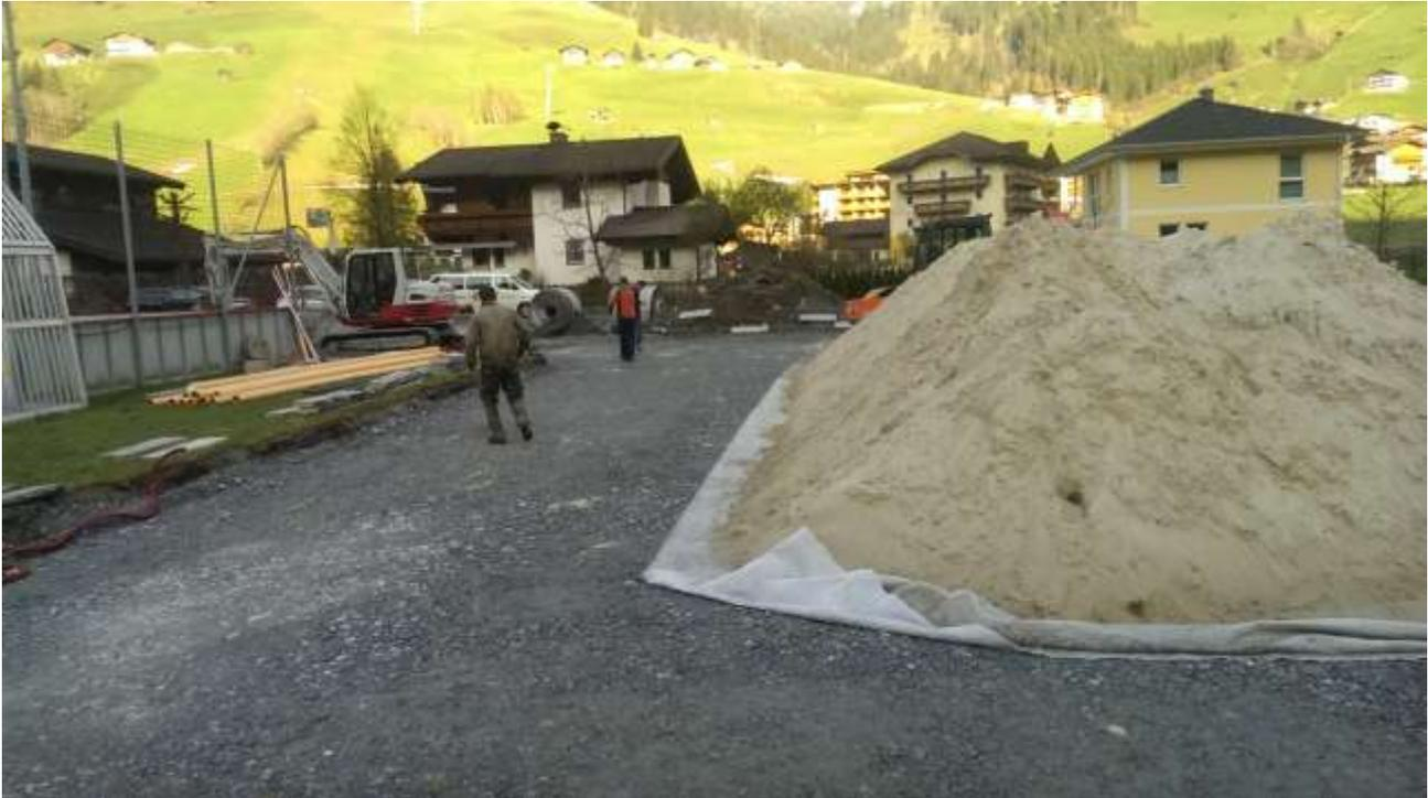
Danach wurden der Unterbau und die Drainage errichtet.
